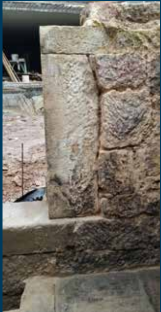
Kämpfer eines früheren Portalbogens der nördlichen Treppenanlage des Kellers, die im 15./16. Jh. zweiphasig errichtet wurde
